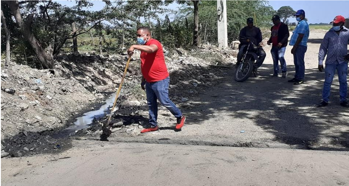
Alcalde supervisa trabajos de limpieza de los drenajes del municipio.
